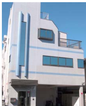
(株)測範社 本社・工場外観
